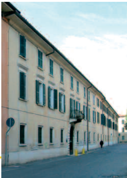
La facciata del Palazzo, oggi sede della villa della Salute, su via Lama.
