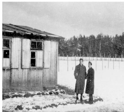
*Figura 13: Finestre prive di vetri, sostituiti con materiali di fortuna*
