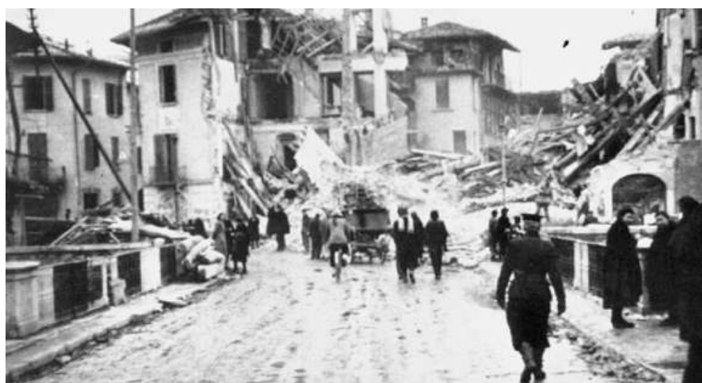
Scene di... ordinaria distruzione. Persone e militari in strada tra gli edifici crollati o lesionati
