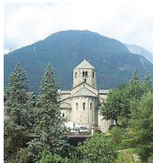
Dove Il monastero di San Salvatore a Capo di Ponte
