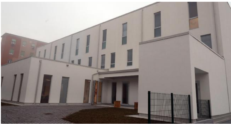
La struttura del dormitorio della San Vincenzo De Paoli è stata inaugurata ieri con la benedizione del vescovo Pierantonio Tremolada. FOTOLIVE
