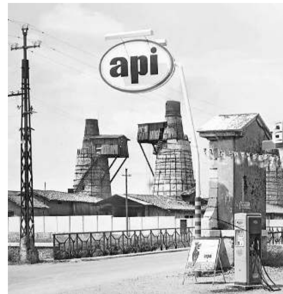
Ponte Crotte. Le fornaci e il vecchio distributore // ARCHIVIO NEGRI
